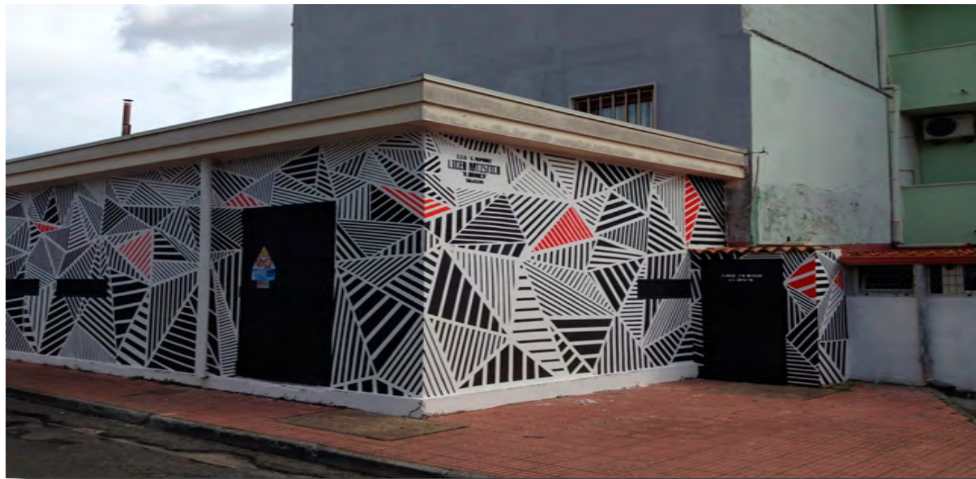
Cabina Enel ad Iglesias
